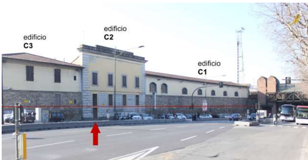
Figura 9 – linea di demarcazione e nuovo ingresso all'edificio C2 realizzato a seguito dell'abbassamento di viale F. Strozzi.
